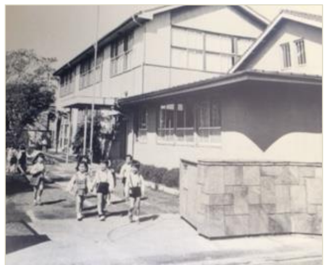
図 6 新園舎第三期工事期 (杉並区松庵)
